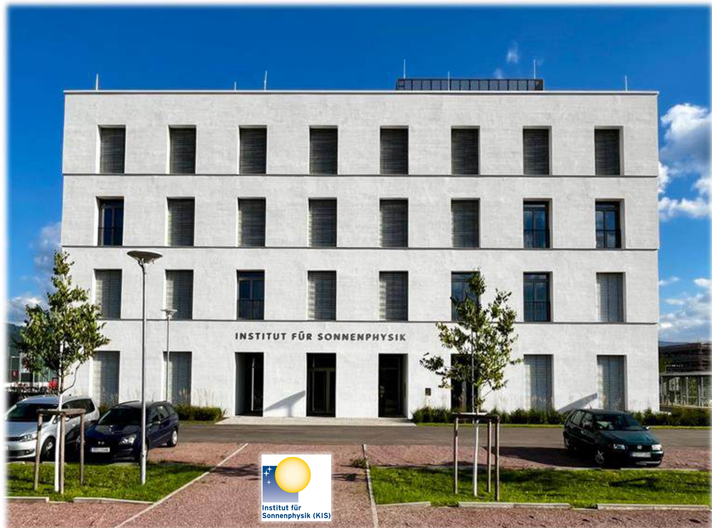
Das Institutsgebäude in der Georges-Köhler-Allee 401A in Freiburg
